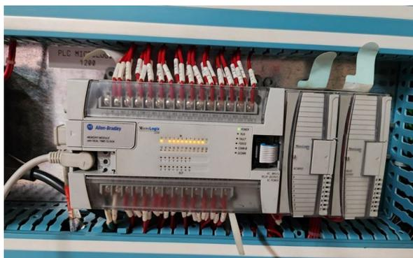
**Figura 4. PLC que controla el sistema de bandas.**
